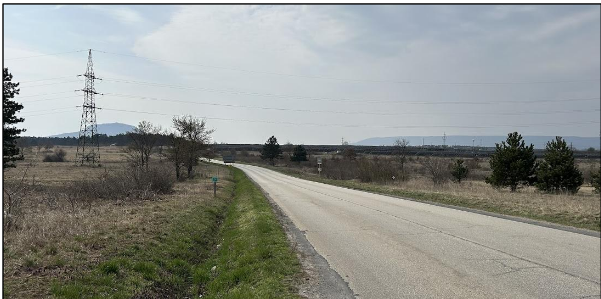
Nagyfeszültségű távvezeték oszlop és napelempark a 7317. sz. út Tapolca-Zalahaláp közötti szakaszán
