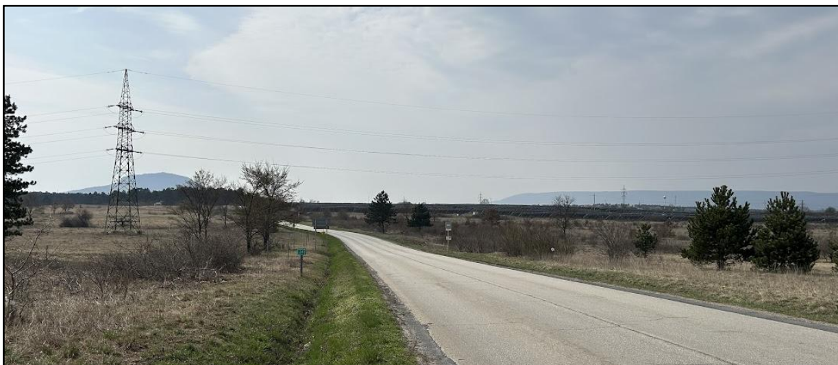
Nagyfeszültségű távvezeték oszlop és napelempark a 7317. sz. út Tapolca-Zalahaláp közötti szakaszán
